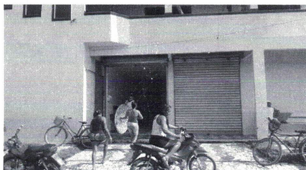
Imagem 01: Vista Frontal do Imóvel
