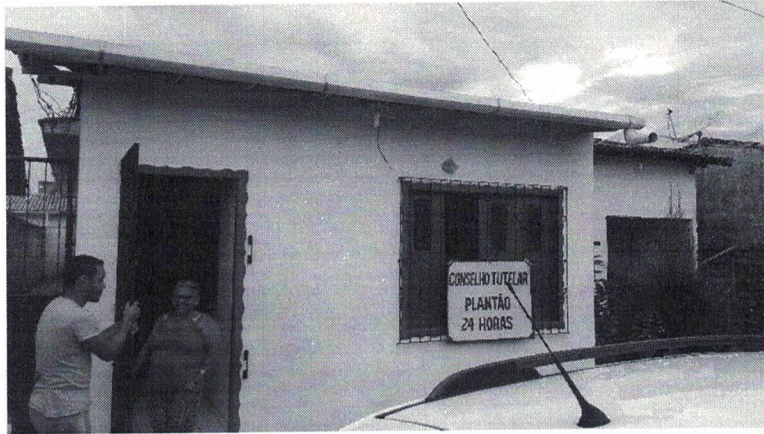
Imagem 01: Vista da Fachada do Imóvel Fonte: Autor, 2017.
